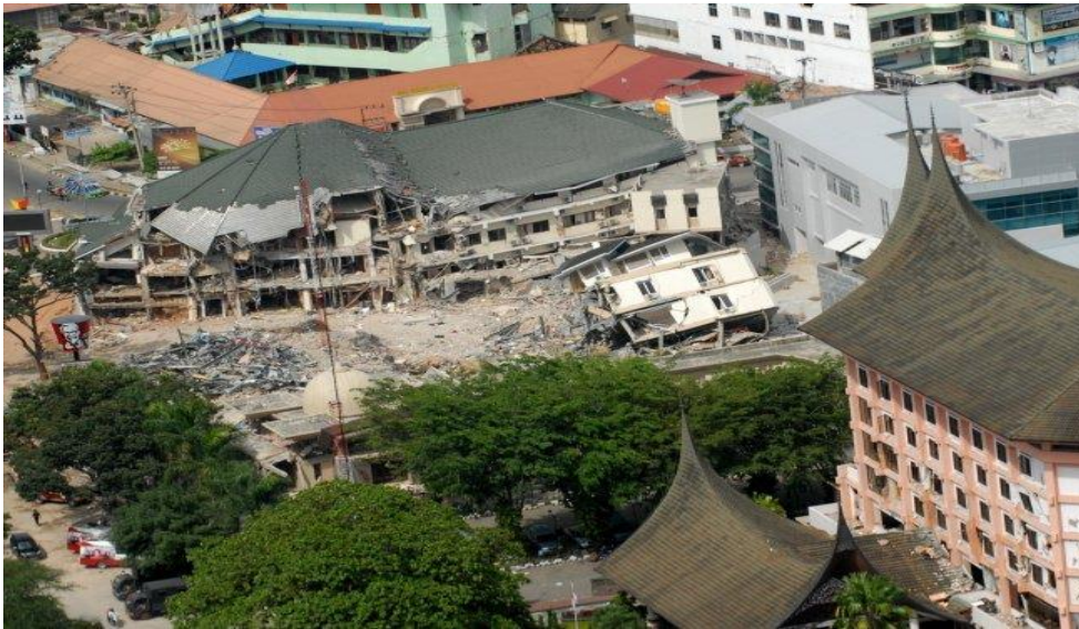
Gambar.1 Kerusakan dan runtuhnya bangunan akibat gempa padang 30 September 2009 (Internet-2).
